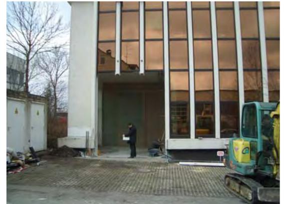
Abfangung der Stahlbeton – Fassadenpfosten im Bauzustand
